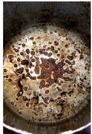
Abb. 3 Granulat, Wasser und Öl in der Lufttrockner-Patrone
