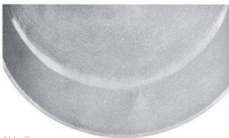
Abb. 2 Glänzende, umlaufende Linie an der Zylinderbohrung
